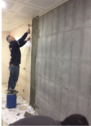
Kadın aile binası fayans çalışması
