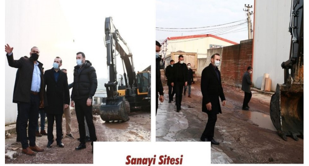
Sanayi Sitesi Asfalt Çalışması
