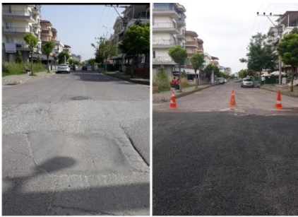
Dere Mahallesi asfalt tamirâtı
