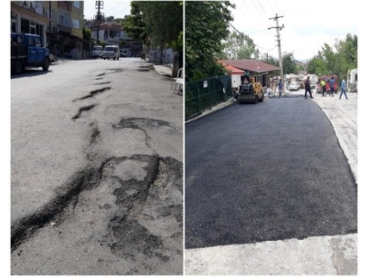
Bağlarbaşı mahallesi tamirâtı
